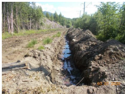
Рисунок 5 – Траншея под укладку кабеля
