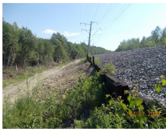
Рисунок 2 – Высокая балластная призма
