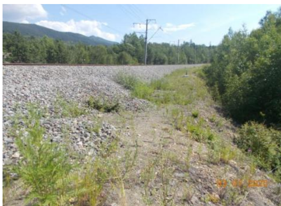
Рисунок 3 – Осадка основной площадки
