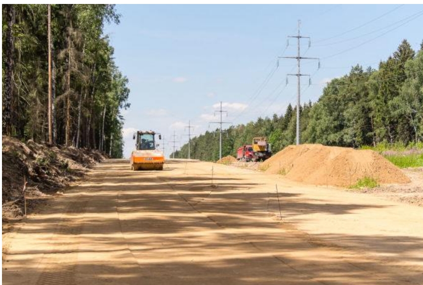
Рисунок 1 – Разбивка земляного полотна
