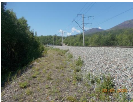
Рисунок 1 – Подпорная стена из шпал
