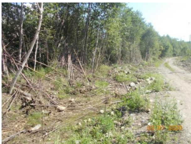
Рисунок 6 – Водоотводная канава на участке
