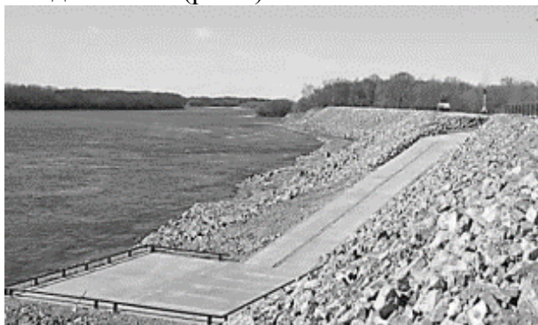
Рисунок 1 – Участок левого берега р. Амур после проведения работ по стабилизации.
