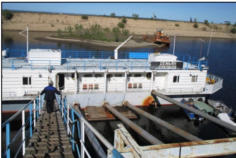
Рис. 1. Вид головной плавучей насосной станции на реке Лена в п. Н. Бестях после реконструкции в 2016 году
