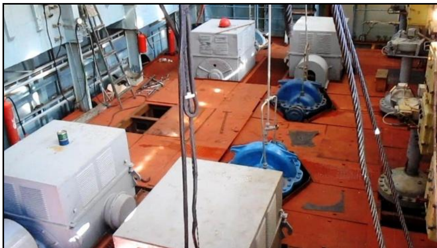
Рис. 2. Машинное отделение ГПНС с насосными агрегатами после ремонта
