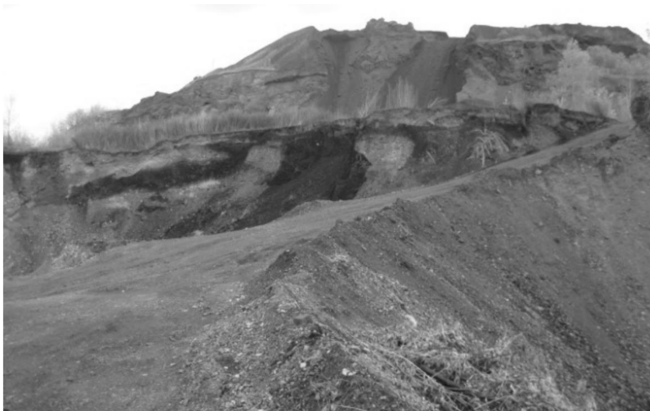
Рис. 4 – Породный отвал обогатительной фабрики «шахта «Капитальная»
