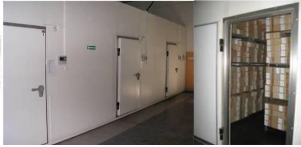
Рис. 25. Холодильная камера SL 14С35 «Финнебэкс» (Швеция): 1 – въездные ворота; 2 – морозильная камера; 3 – холодильная камера.
